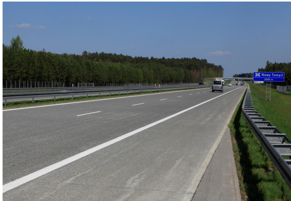
Autostrady A2 – odcinek koncesyjny Autostrada Wielkopolska
